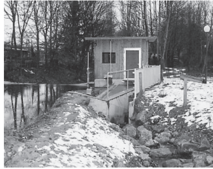
Kraftwerk Sursee, Sursee
