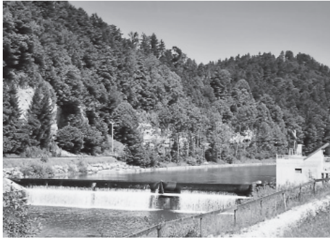
Kraftwerk Wannenfloh, Rüderswil
